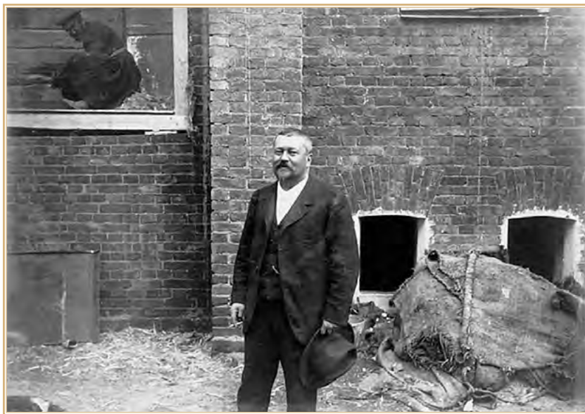
Савва Тимофеевич Морозов на строительстве здания Московского Художественного театра. Фото 1901 г.
